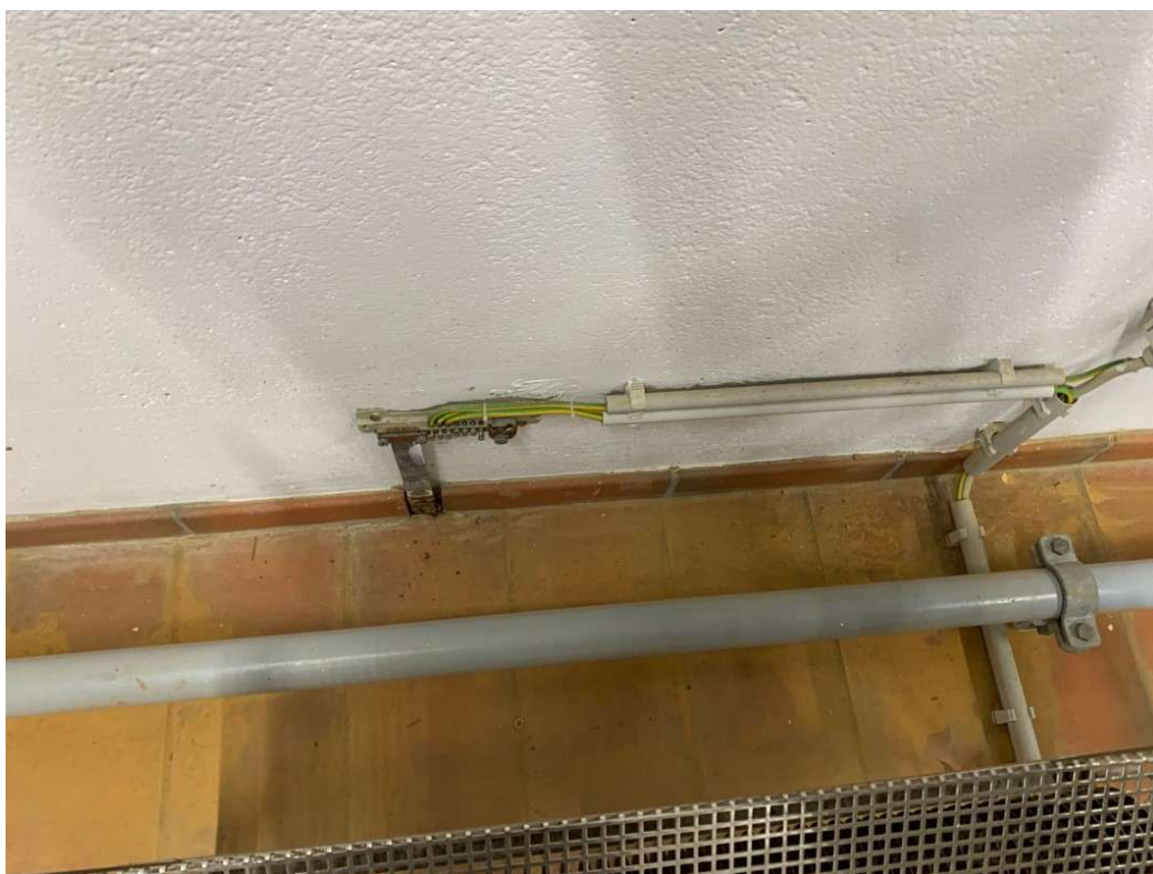
Abbildung 3.1B: Potenzialausgleich Gebäude
